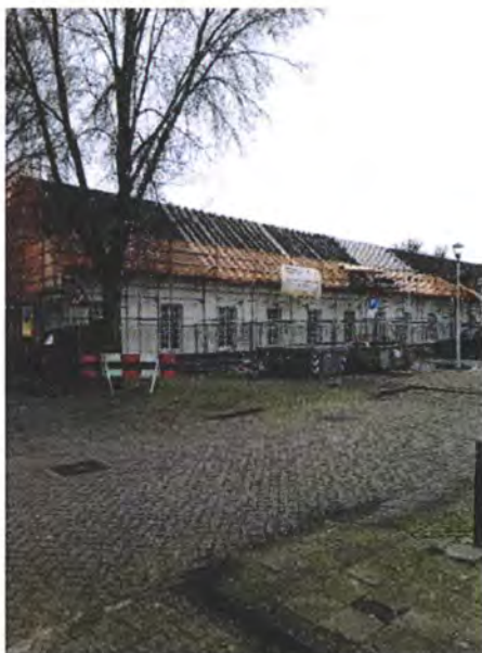
Werkzaamheden in volle gang
